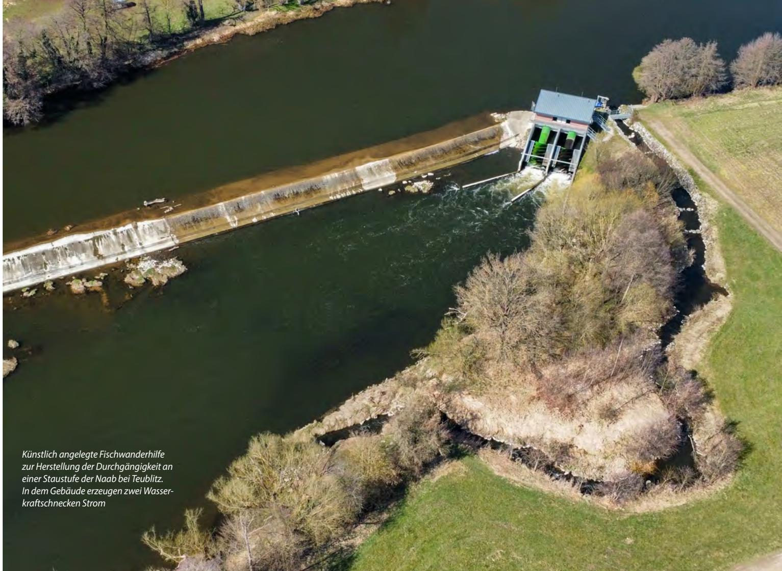
*Künstlich angelegte Fischwanderhilfe zur Herstellung der Durchgängigkeit an einer Staustufe der Naab bei Teublitz. In dem Gebäude erzeugen zwei Wasserkraftschnecken Strom*
